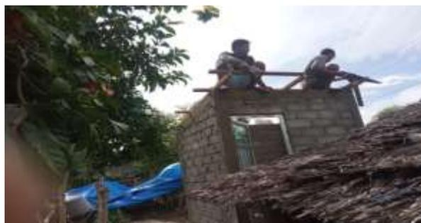
Gambar 4. Pemasangan Atap Jamban
